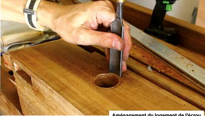
Aménagement du logement de l'écrou
